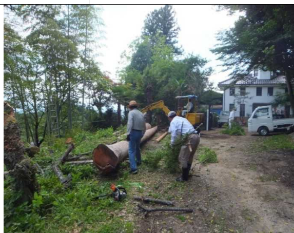
駐車場の基盤整備へ
