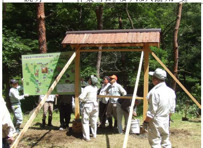
説明 看板を木枠に取り付ける。
