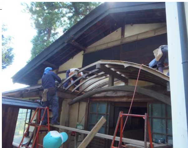
母屋玄関屋根の破風復元作業
