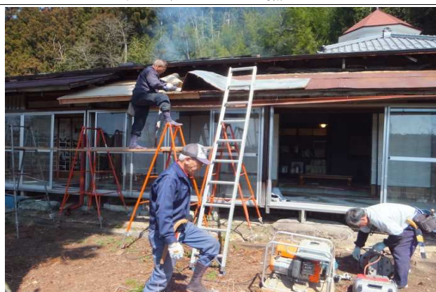
母屋屋根の補修作業
