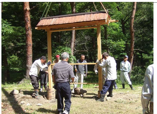
説明 水平を見て木枠を入れ、生コンを注入
